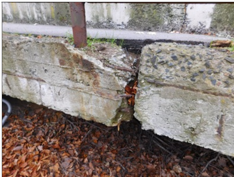
Degradace betonu římsy.
