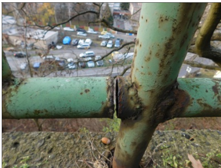
Koroze zábradlí.
