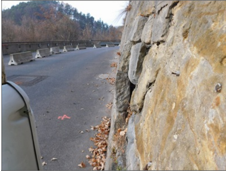
Vyboulené zdivo zárubní zdi v místě skalního výchozu (cca km 0,2).
