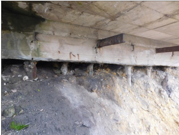
Obnažené hlavy mikropilot v místě sesuvu svahu (cca střední část galerie).
