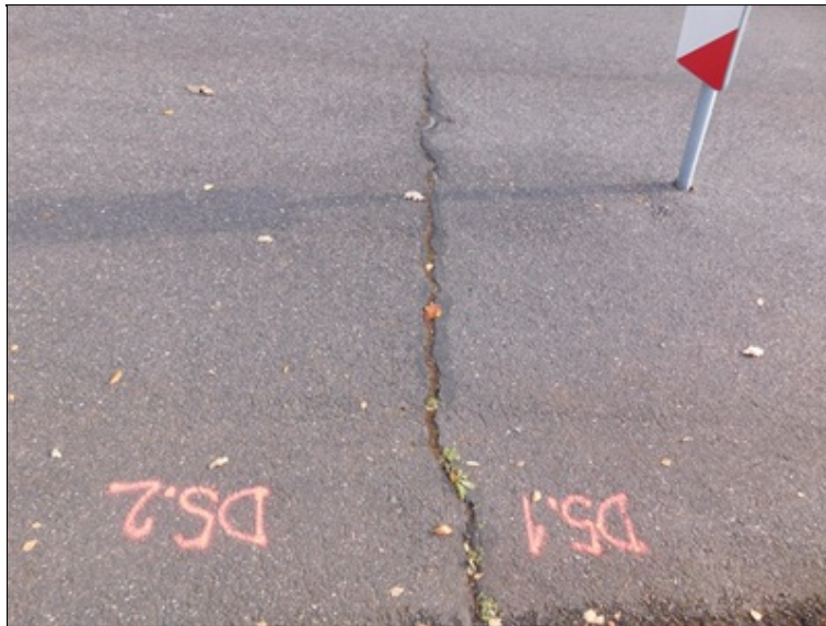
Trhlina ve vozovce v místě dilatační spáry.
