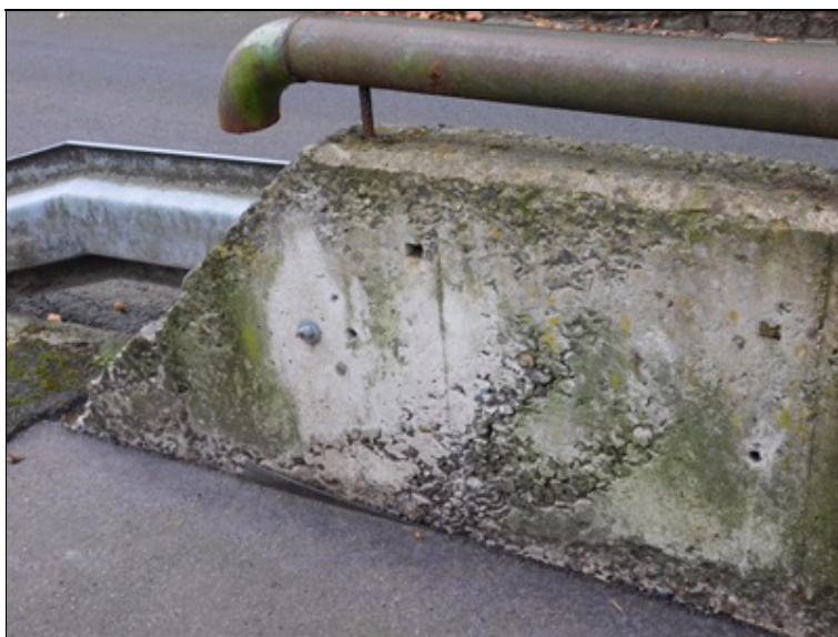
Štěrkové hnízdo v zábradelní zídce.
