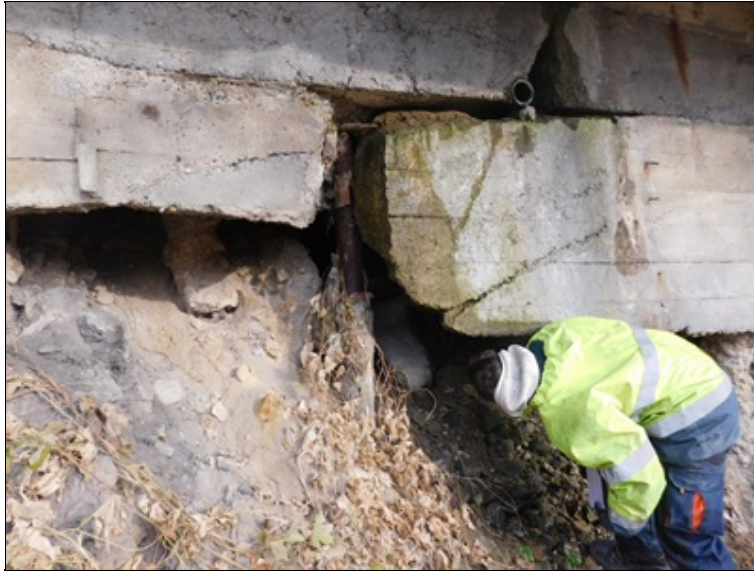
Eroze a vzniklá kaverna v místě zatékání 2. dilatační spárou.
