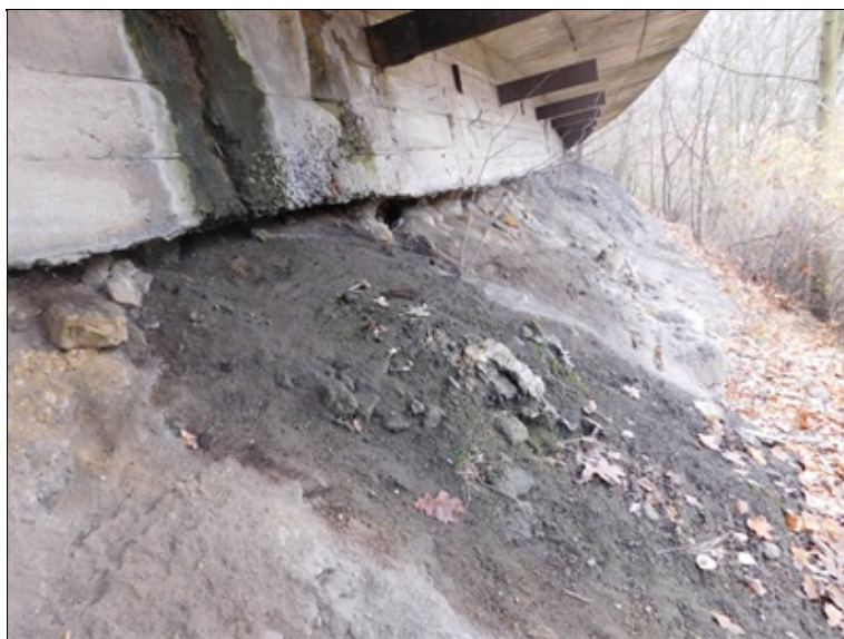
Zatékání dilatační spárou do svahu pod galerií.
