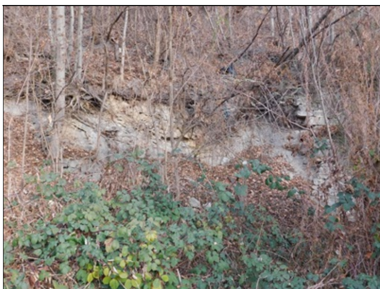
Rozpad opěrné stěny pod galerií.
