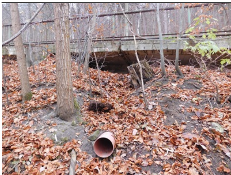
Vyústění odvodňovací trubky příčné drenáže na konci galerie.
