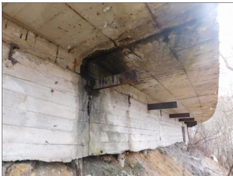
Zatékání dilatační spárou.
