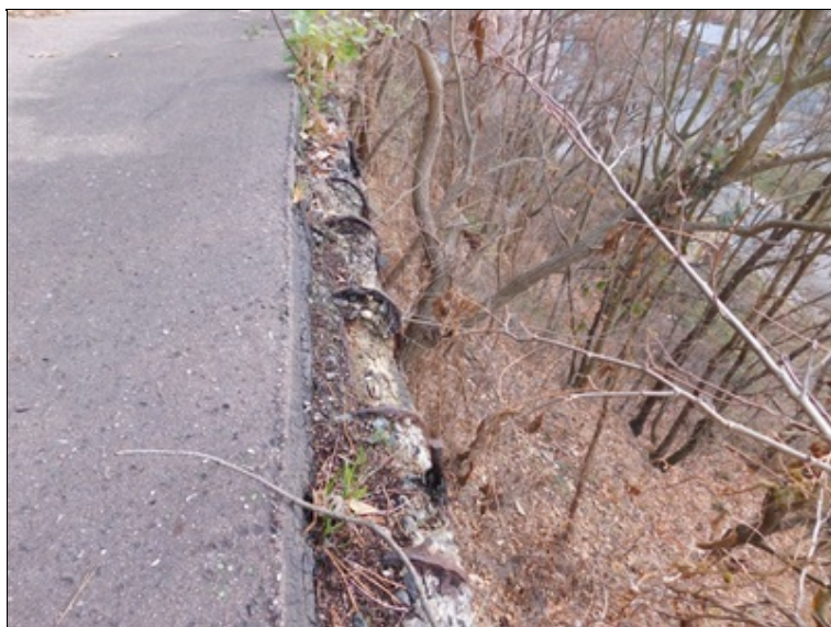
Obnažená korodující výztuž římsy.
