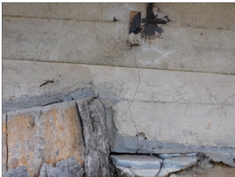
Svislá trhlina v úložném prahu.
