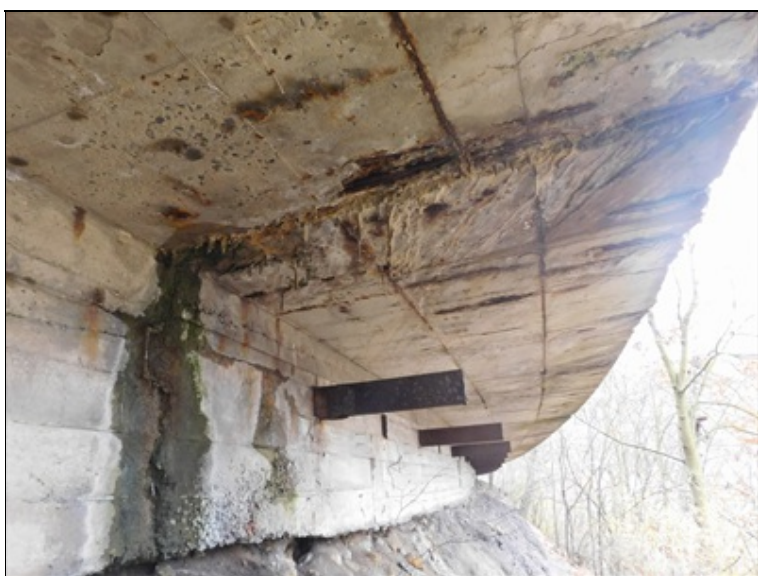
Výrazné zatékání dilatační spárou.
