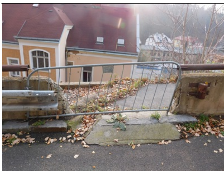
Provizorní záchytný systém ve spodní části galerie.
