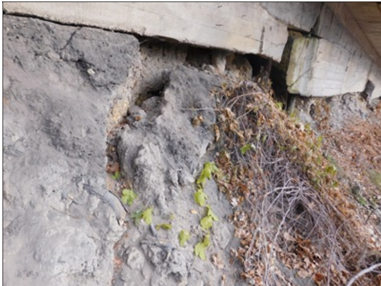
Zátrh ve svahu - část svahu na hranici stability - v místě 2. dilatační spáry.
