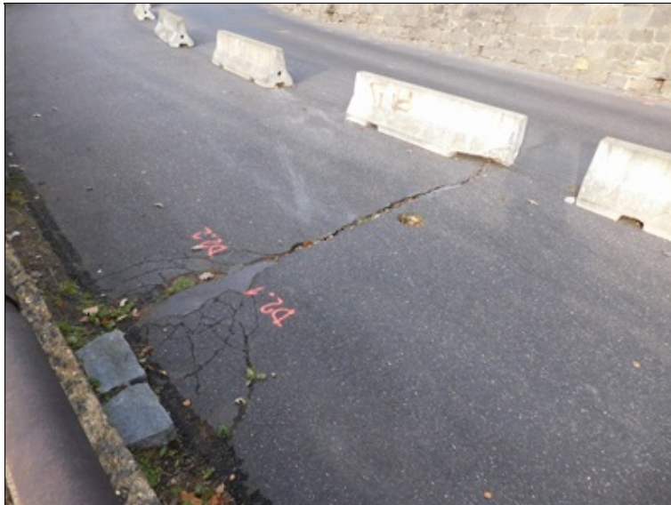
Netěsná trhlina ve vozovce v místě dilatace - pod opěrou galerie v tomto místě vznikla výrazná kaverna.
