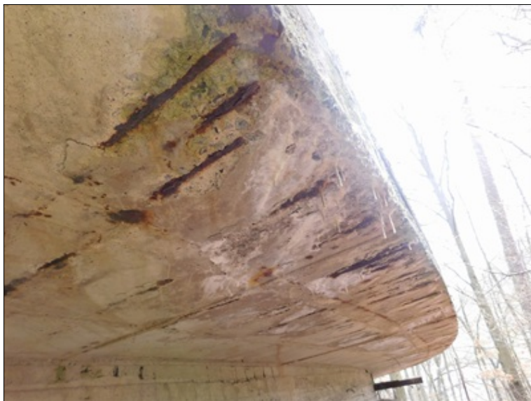
Koroze výztuže a zatékání s výluhy na pohledu konzoly galerie.
