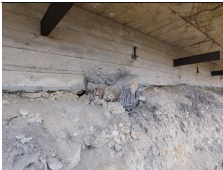
Ponechaný pařez v místě úložného prahu.
