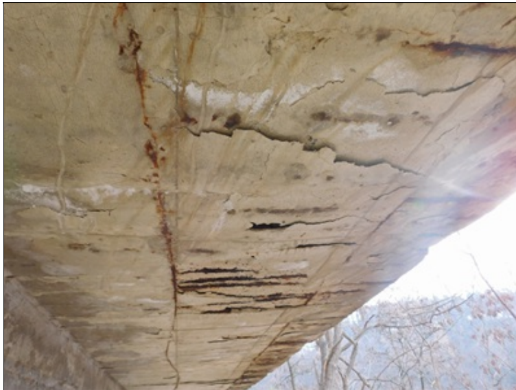
Podhled konzoly galerie - separace krycí vrstvy betonu.
