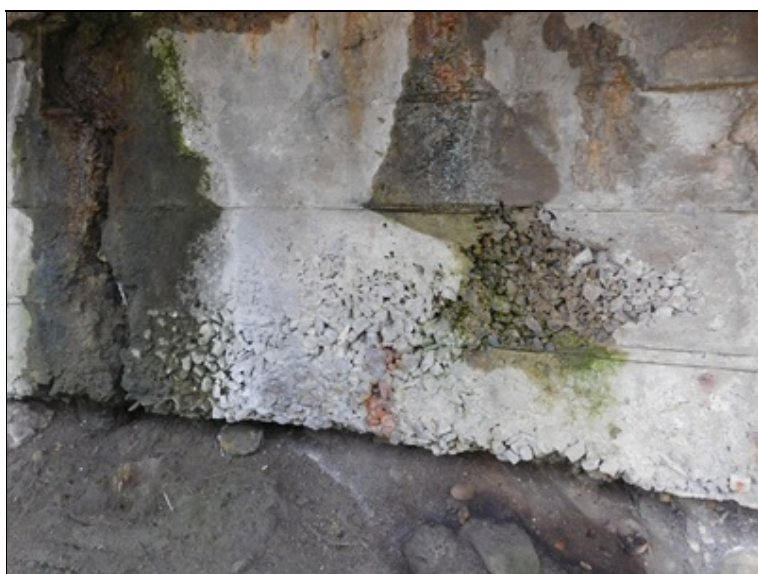
Štěrkové hnízdo v úložném prahu galerie.
