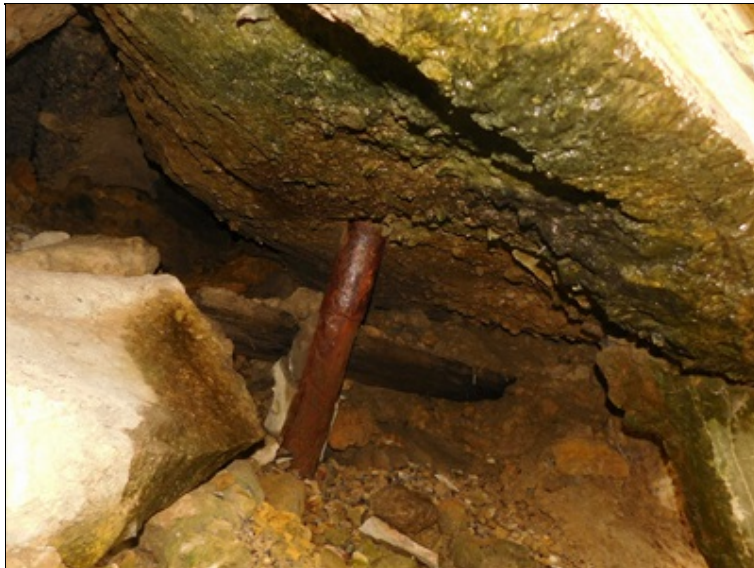
Pohled do kaverny - koroze hlavy mikropiloty, značně vlhké prostředí.
