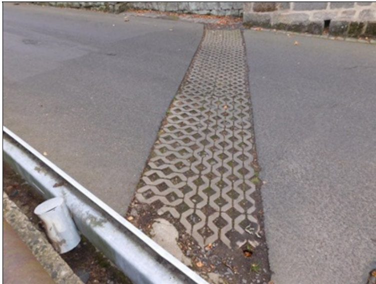
Příčná odvodňovací drenáž na konci galerie.
