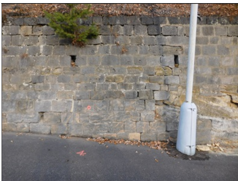
Stav zdiva zárubní zdi v místě skalního výchozu (cca km 0,2).
