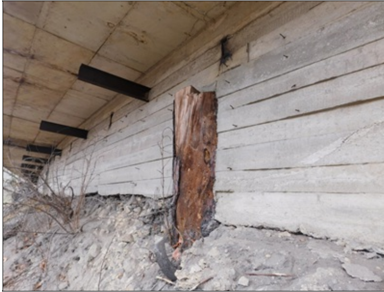
Ponechaný pařez zabetonovaný v úložném prahu.
