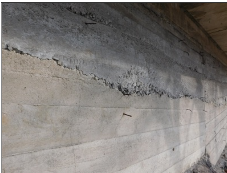
Štěrkové hnízdo v rozhraní 2 různých betonů.
