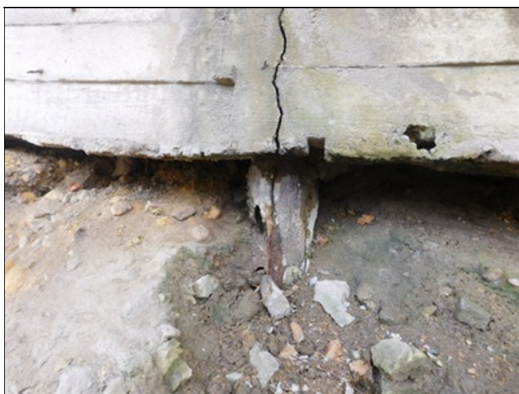
Obnažená korodující hlava mikropiloty, nad ní je svislá trhlina.
