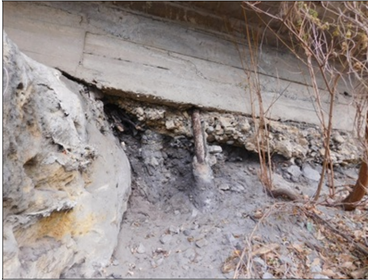
Eroze svahu - obnažená mikropilota v místě skalního výchozu.
