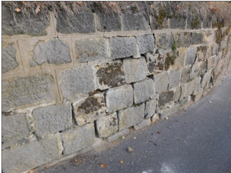
Vypadané spárování zárubní zdi.
