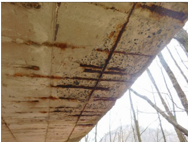
Výrazná koroze výztuže na pohledu konzoly galerie.
