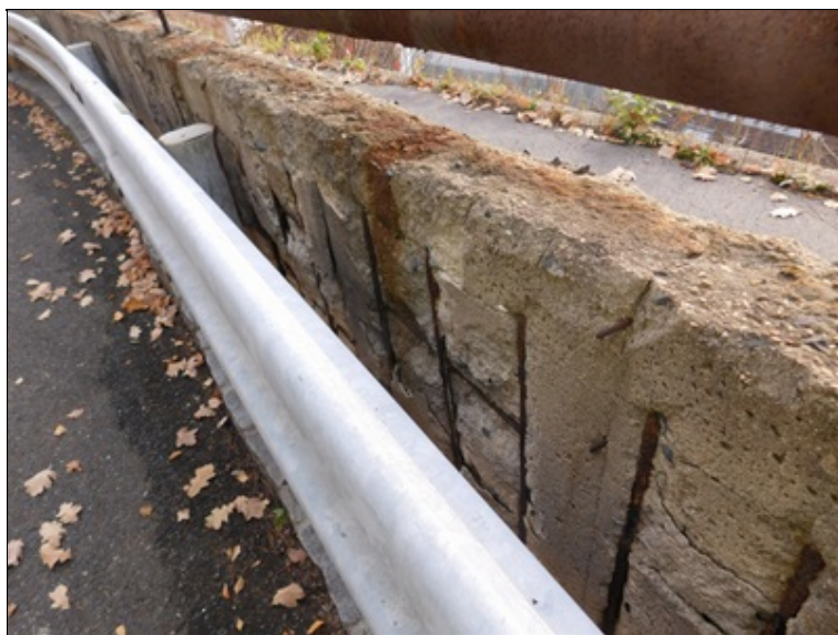
Odpadlá krycí vrstva a koroze výztuže v zábradelní zídce.
