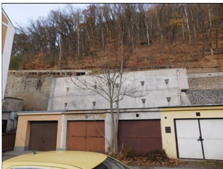
Pohled na opěrnou kotvenou stěnu na začátku galerie.
