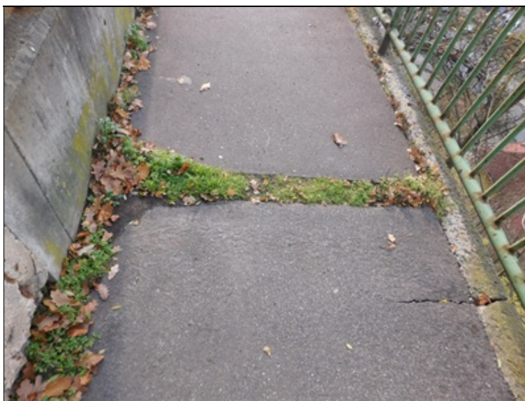
Dilatační spára v chodníku - vegetace, netěsná.
